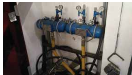
Figura 7. Sistema de alimentação de sopro do TA-2.
