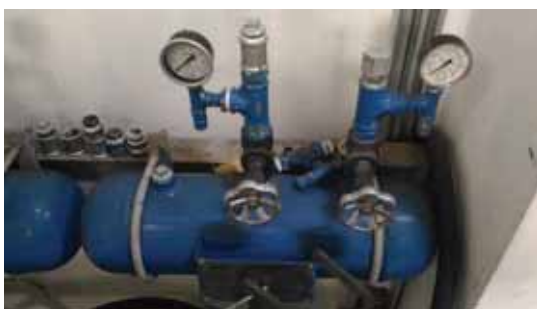
Figura 7. Sistema de alimentação de sopro do TA-2.
